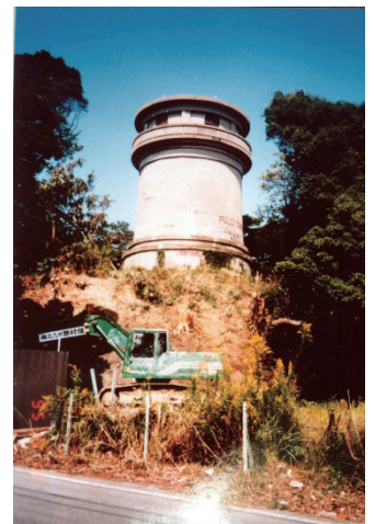
重機で穴を空けられた給水塔（95年10月）筆者撮影
