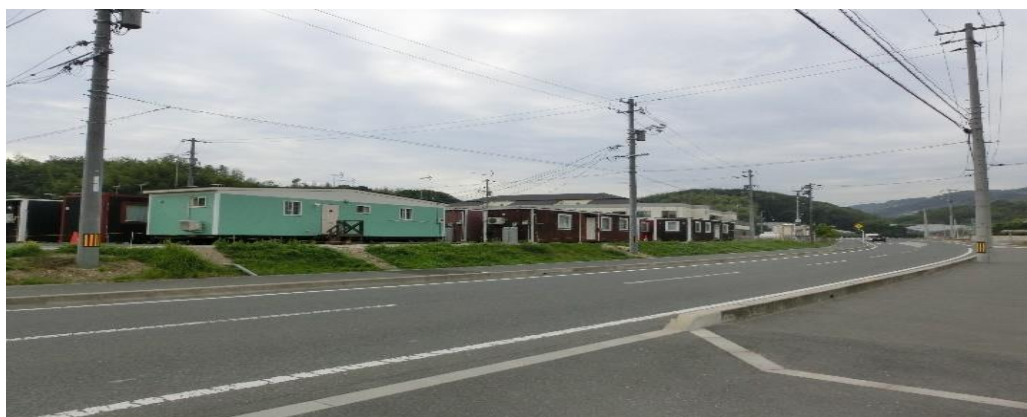
写真 3 トレーラーハウスタイプの仮設住宅 (10 月撮影)
