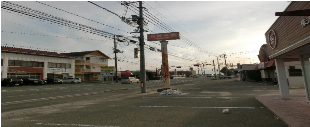
写真4 真備地区有井の国道沿いの被災した事業所集積エリア（10月撮影）
